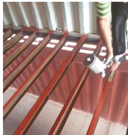
Primario a estructura
