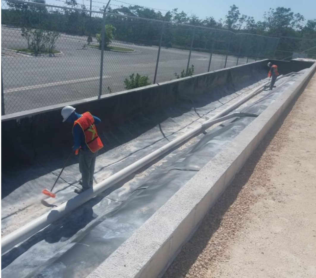
Limpieza de canal captador de agua de lluvia para entrega 100%
