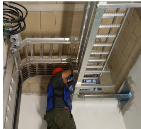
Colocación al interior cuarto eléctrico (canalización al 100% )
