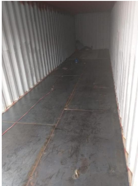
Colocación de piso
